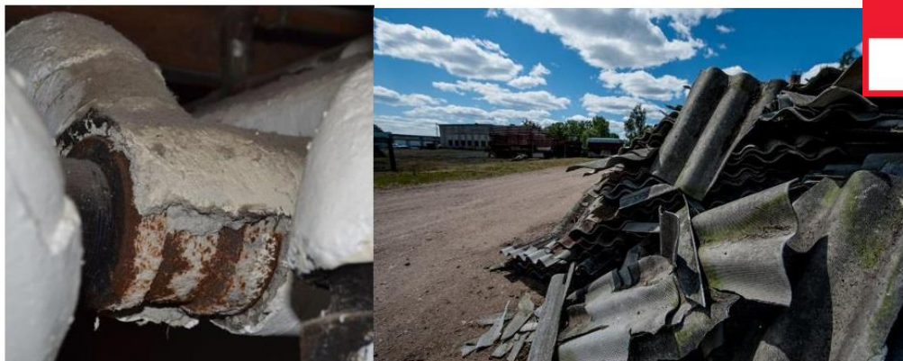
13 pav. Asbesto atliekų pavyzdys (1)
